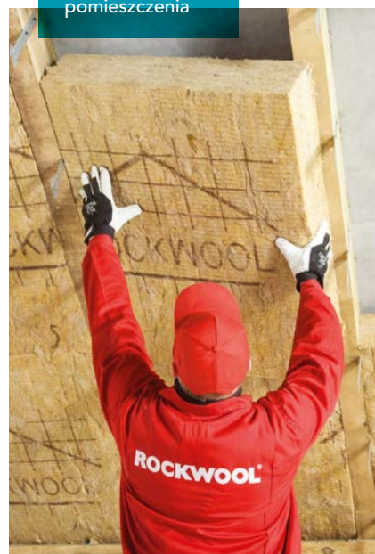
Ułożenie maty oznakowaną stroną w kierunku pomieszczenia
