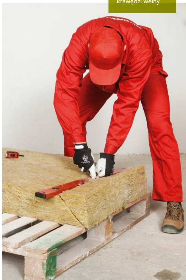
Przycięcie krawędzi wełny
