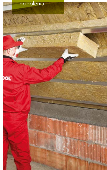
Układanie drugiej warstwy ocieplenia
