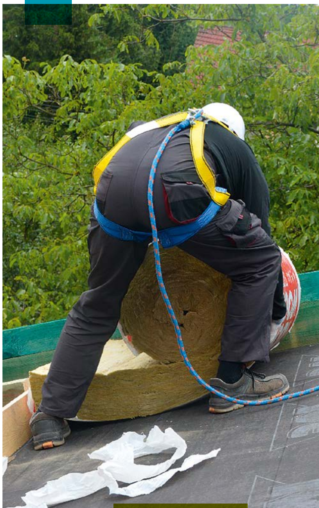
Układanie pierwszej warstwy izolacji
